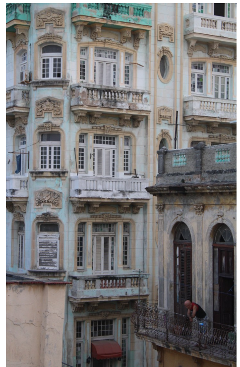
Edificio en Centro Habana. Foto: ICLEP
