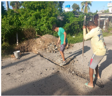
Vecinos de Jaimanitas sacando acometida de la tubería madre. Foto: ICLEP
