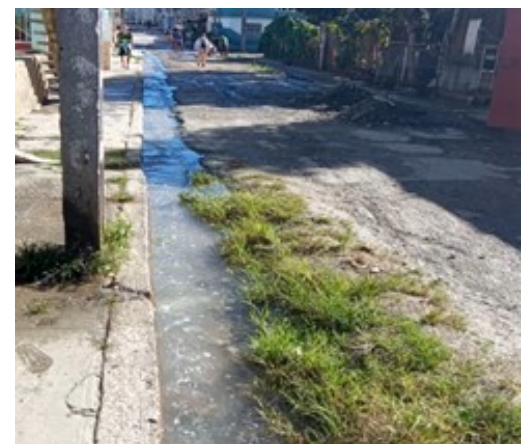
Salidero en calle Ancha del norte. Foto ICLEP
