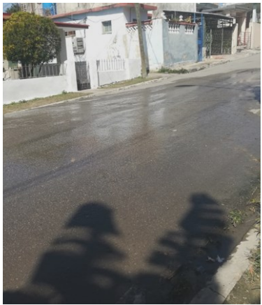
Calle 1era. entre avenida Rotaria y Vía Blanca, municipio Regla. Foto: ICLEP
