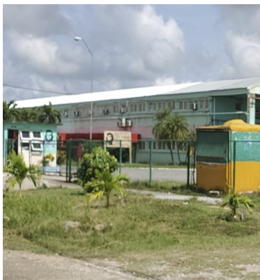
Fábrica Troncoso: Foto ICLEP
