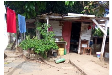
Vivienda sin piso. Foto ICLEP
