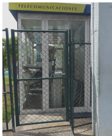
Telepunto, calle 102. Foto: ICLEP
