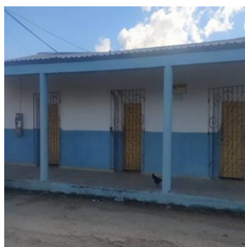
Bodega. Foto ICLEP
