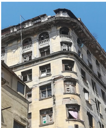
Edificio, calle Águila. Foto: ICLEP
