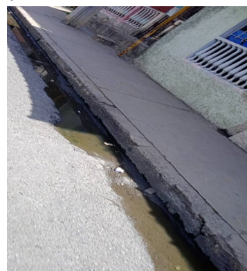
Vertimiento de la fosa comunal en la calle Antonio Maceo: Foto ICLEP
