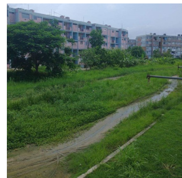
Salidero de agua potable. Foto: ICLEP
