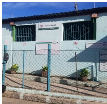
Punto de gas. Foto ICLEP
