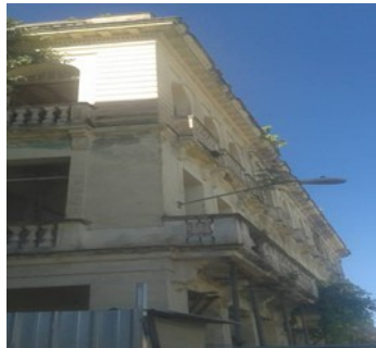
Edificio. Foto ICLEP
