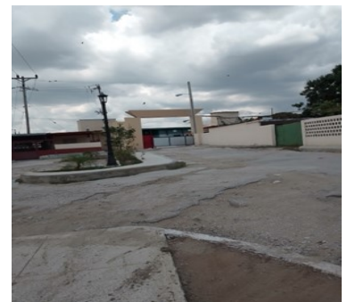
Fábrica de Baldosas. Foto ICLEP
