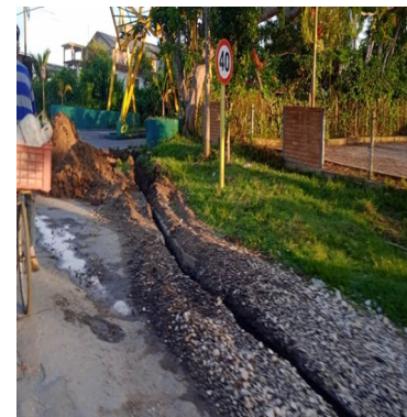
Reparación del salidero del Km 1 de la carretera a Viñales: Foto ICLEP
