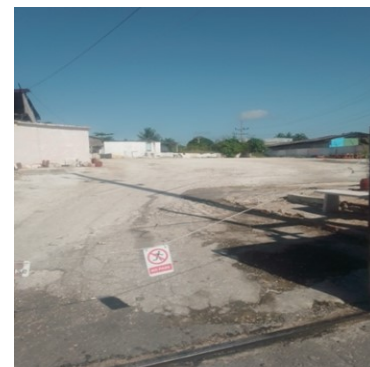
Patio de materiales. Foto ICLEP
