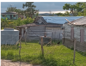
Techo con manta de nylon: Foto ICLEP
