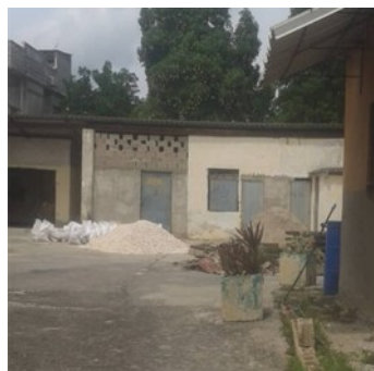
Patio de materiales. Foto ICLEP
