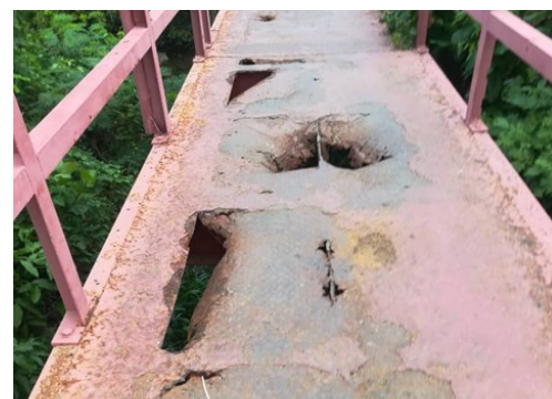
Puente peatonal. Foto: ICLEP
