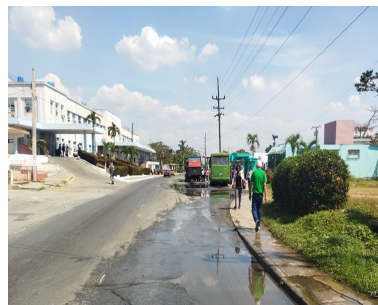
Salideros de agua: Foto ICLEP
