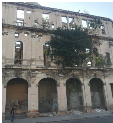
Edificio en Ayesterán entre Carlos III y Estrella, municipio Centro Habana. Foto: ICLEP
