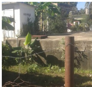
Cisterna. Foto ICLEP
