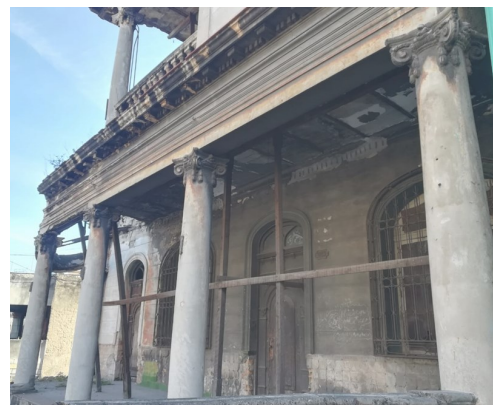
Edificio en la Calzada de 10 de Octubre no. 1213 entre Carmen y Acosta. Foto: ICLEP
