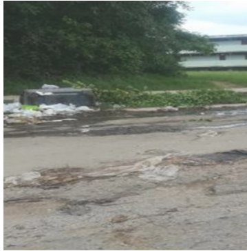
Microvertedero, parte trasera de la escuela Salvador Allende, Habana del Este. Foto: ICLEP
