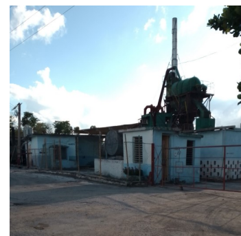
Planta de Asfalto. Foto ICLEP
