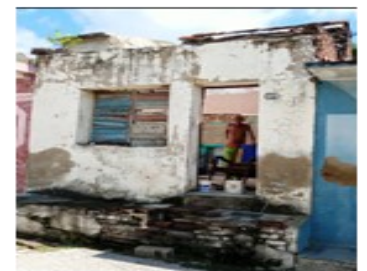
Casa de Rolando. Foto ICLEP
