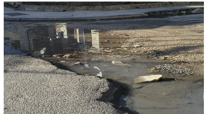
Salidero de aguas negras. Foto: ICLEP
