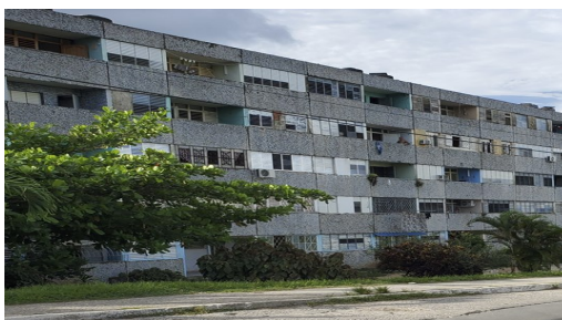
Edificio multifamiliar: Foto ICLEP
