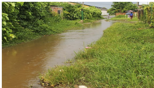
Calle del reparto: Foto ICLEP
