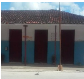
Bodega. Foto ICLEP
