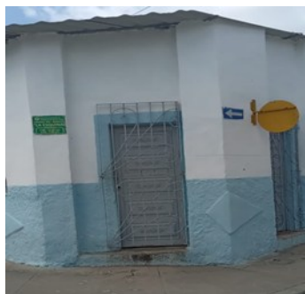
Bodega . Foto ICLEP
