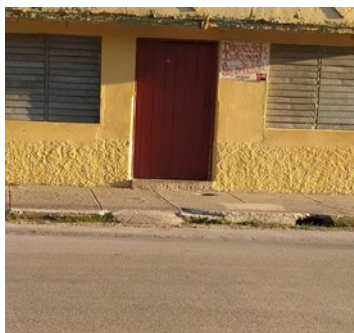
Sede de inspección. Foto ICLEP
