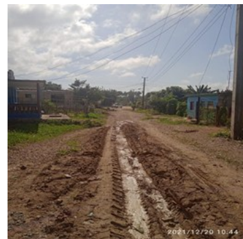
Carretera Los Patos. Foto ICLEP
