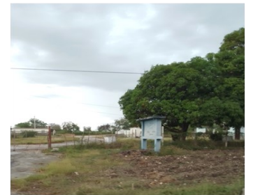
Planta de asfalto. Foto ICLEP
