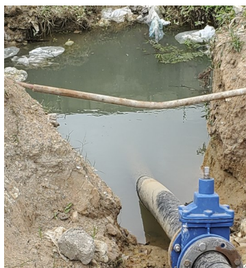
Conductora rota. Foto: ICLEP
