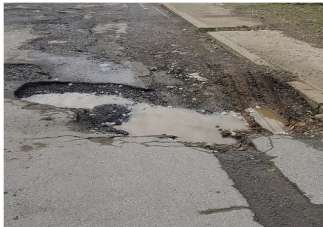
Hueco de la Avenida 91. Foto: ICLEP
