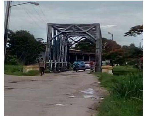
Puente río Mayabeque. Foto: Archivo ICLEP
