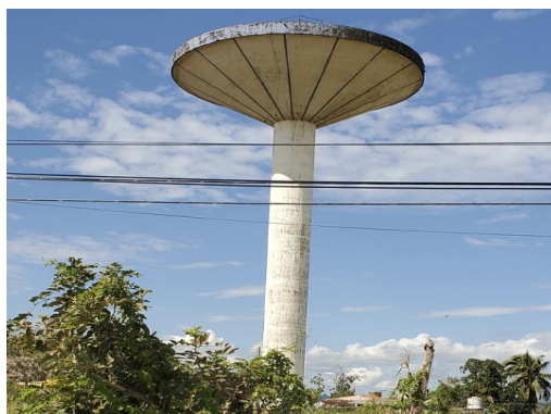
Tanque de agua: Foto ICLEP
