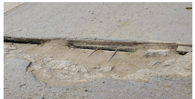
Puente viejo de la circunvalación. Foto: ICLEP
