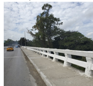
Puente del río Guamá: Foto ICLEP
