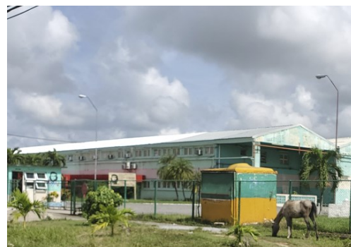
Fábrica Troncoso: Foto ICLEP
