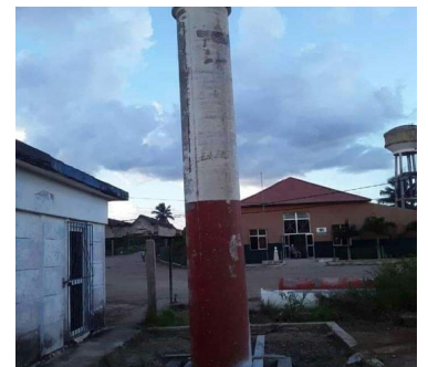
Radio base en construcción. Foto: ICLEP
