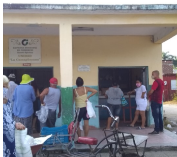
Bodega afectada. Foto ICLEP
