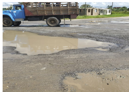
Entrada a la carretera para Siete Matas: Foto ICLEP
