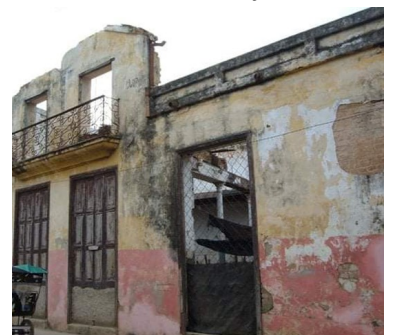
Antigua Bodega de calle 84. Foto: ICLEP
