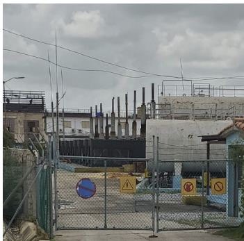
Grupo electrógeno pinareño: Foto ICLEP
