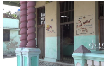
Tienda de productos normados. Foto ICLEP.
