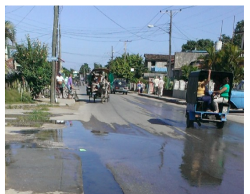
Salideros de agua. Foto: ICLEP
