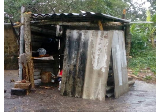
Cocina de la casa de Yanet. Foto: ICLEP
