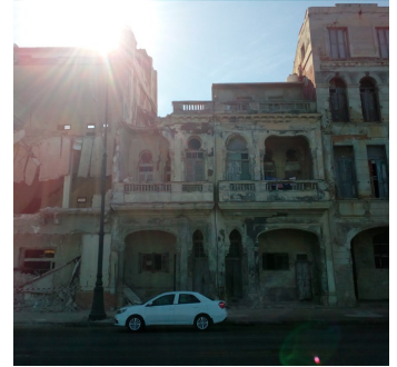
Edificio 313. Foto: ICLEP
