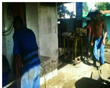
Fábrica de materiales. Foto: ICLEP
