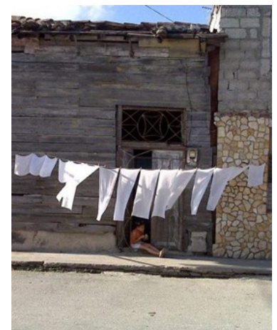
Aunque el fondo habitacional está en pésimo estado, conseguir materiales de la construcción es complicado (Foto ICLEP).
